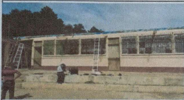
Foto1: Cambio de lámina del módulo 3
