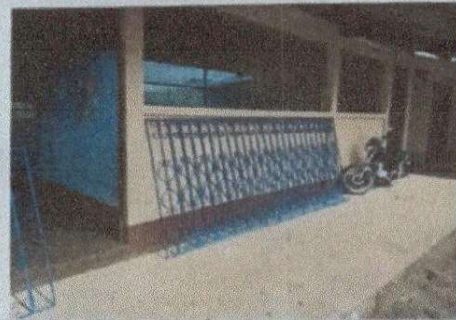
Foto 2: Colocación de balcones módulo 2
