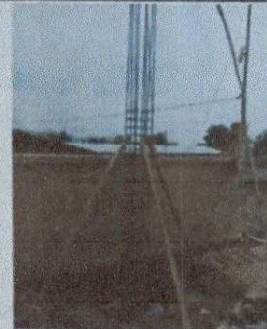
Foto 4: Preparando fundición de base para cisterna de depósito de agua
